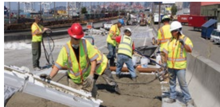
➤ Construcción de losas de concreto simple con juntas. Cortesía: Flickr - WSDOT
